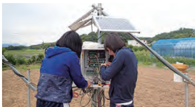
現場観測機器設置の様子
