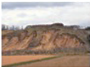
斜面崩壊現場例
