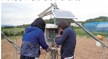
現場観測機器設置の様子
