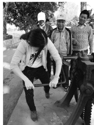
写真-1 大英帝国時代の水門ゲートの開閉は手動操作でできる
